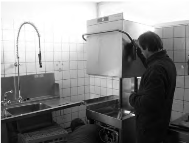
Die neue Spülmaschine wird eingebaut
